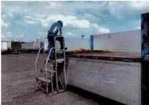
墜落・転落防止:昇降台の導入
