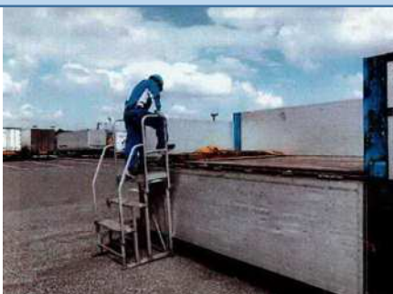
墜落・転落防止：昇降台の導入
