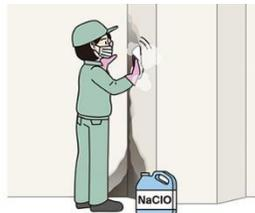
食品製造工場の通路において、次亜塩素酸ナトリウムを含有するカビ取り用洗剤を使用して、通路の壁のカビ取り作業を行っていた際に、汚れの落ちが悪いため、**通常500倍に希釈して作業するところ、洗剤を希釈せずに原液のまま使用**した。帰宅後、息苦しい等の症状が発生したため病院を受診したところ、**次亜塩素酸ナトリウム中毒**と診断された。
